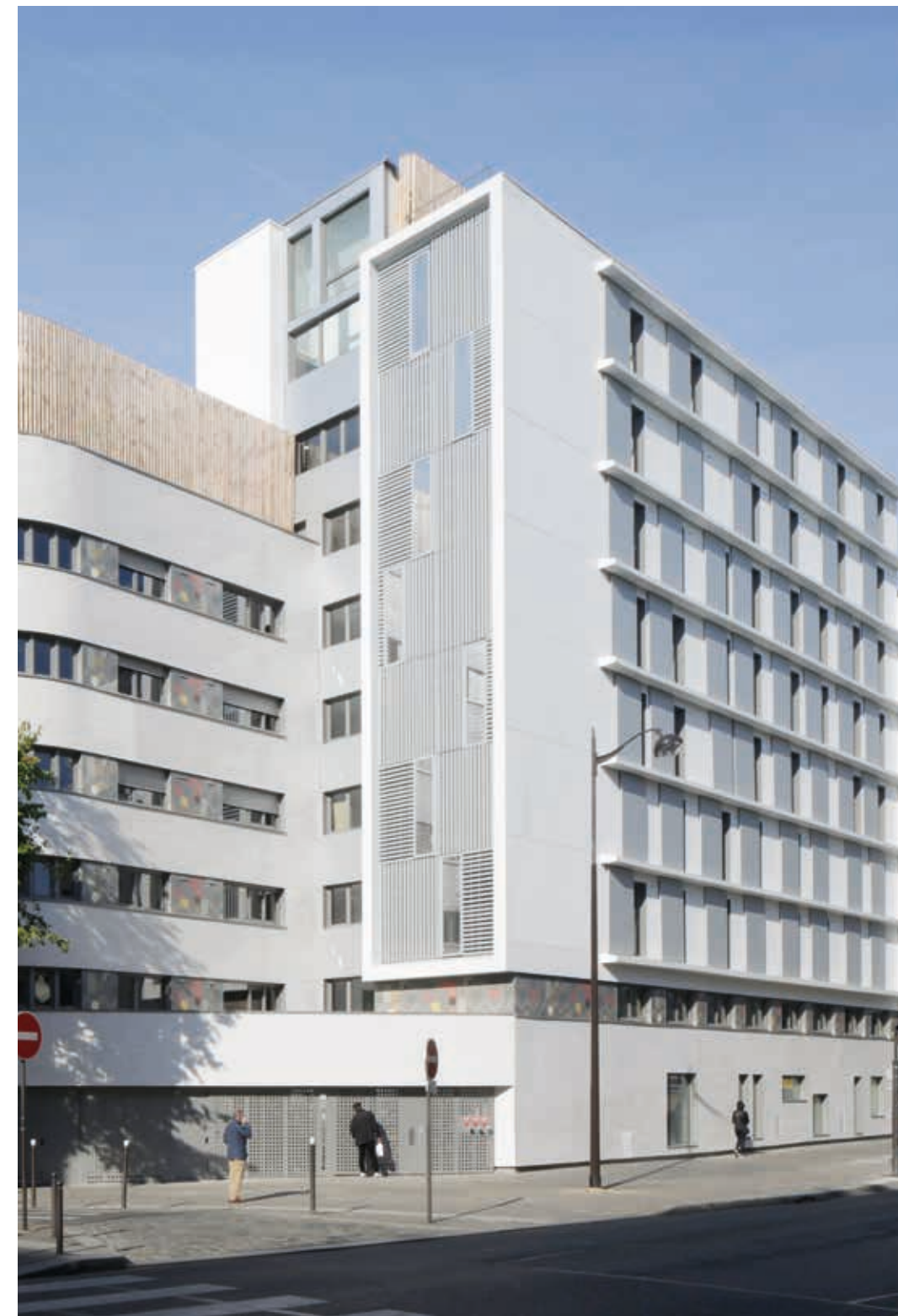
Clisson - Paris Armatern Parement - Système AQUAPANEL® Outdoor avec une finition parements collés ou enduit
