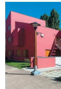
REVÊTEMENTS DE FAÇADES
