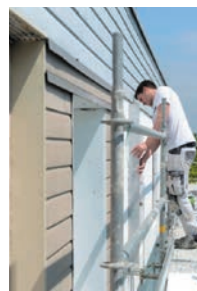
ISOLATION THERMIQUE PAR L'EXTÉRIEUR
