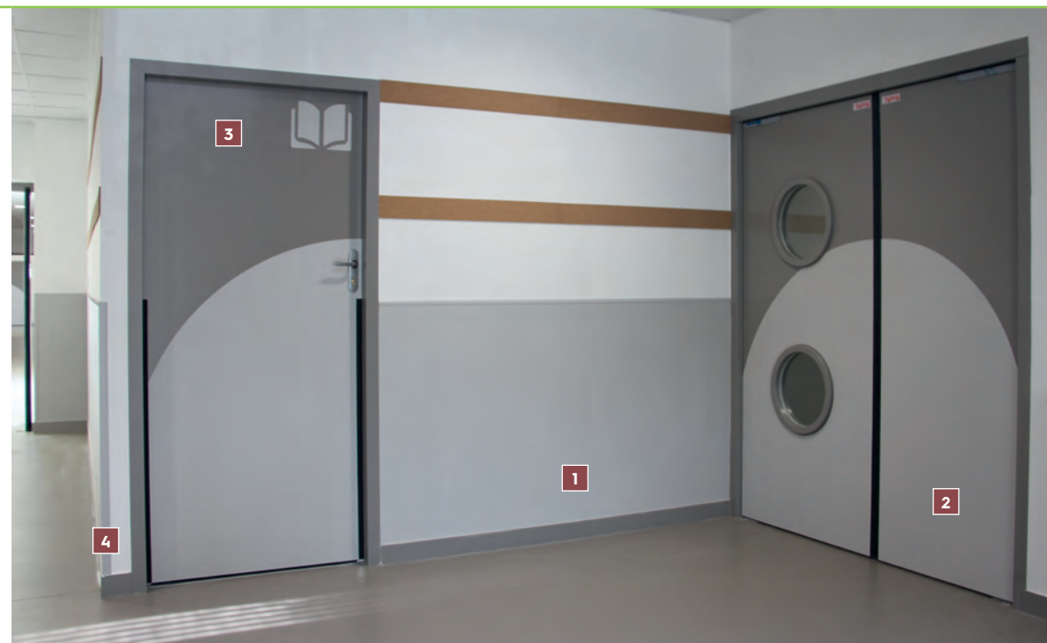
1 PANNEAU DECOCHOC AVEC PROFILÉ DE FINITION FIN'COLOR / 2 PANNEAU DECOCHOC 1/2 PORTE DÉCORATIVE / 3 PANNEAU DECOCHOC SIGNALÉTIQUE INCRUSTÉE / 4 CORNIÈRE PROFILA 30
