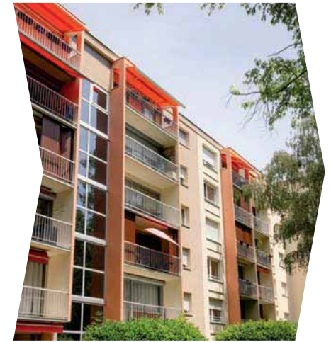
Chantier ITE Zolpan - Rixheim
