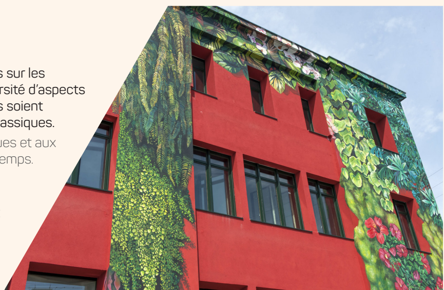
Chantier Zolpan : École Jean Jaures à Lyon-69600 Oullins
