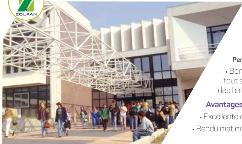
Chantier Zolpan - Lycée - Savoie
