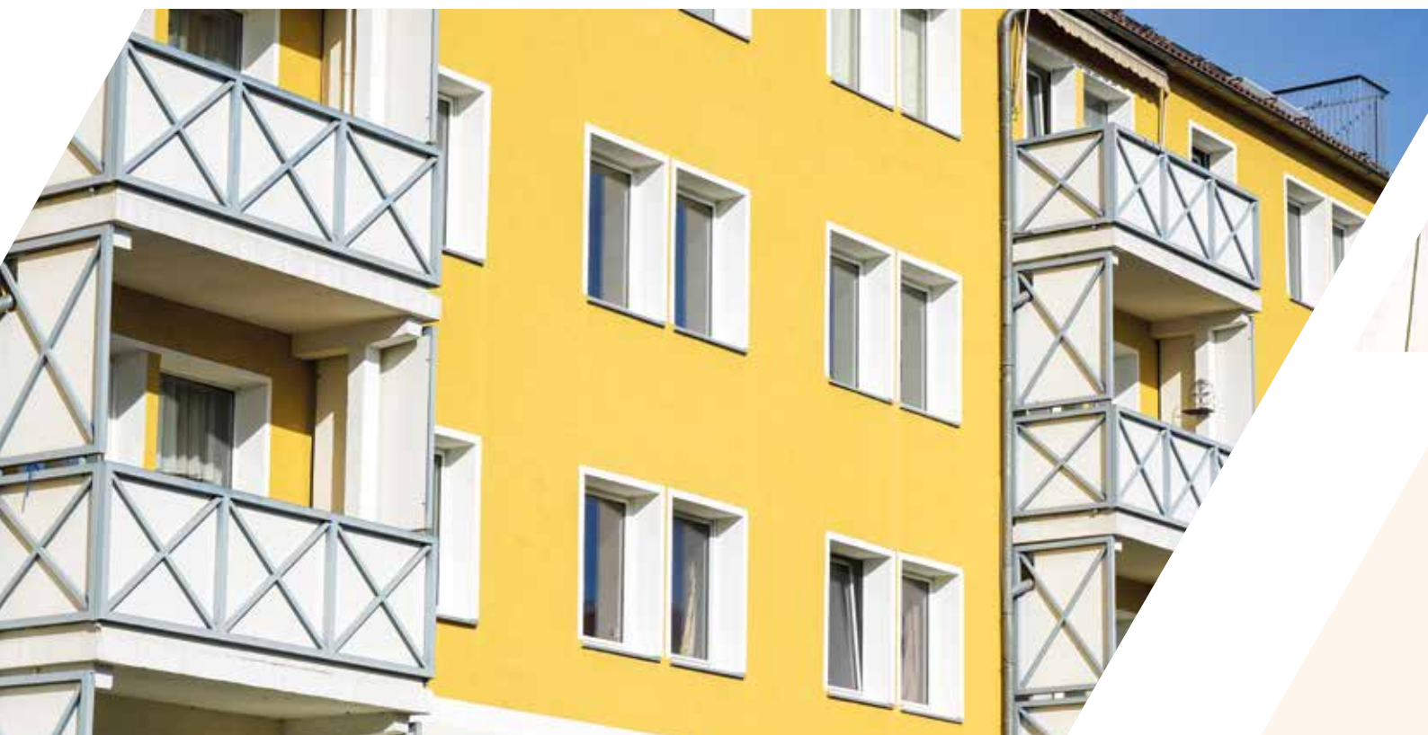
Chantier Zalpan - Terre Neuve - Villefranche sur Saône
